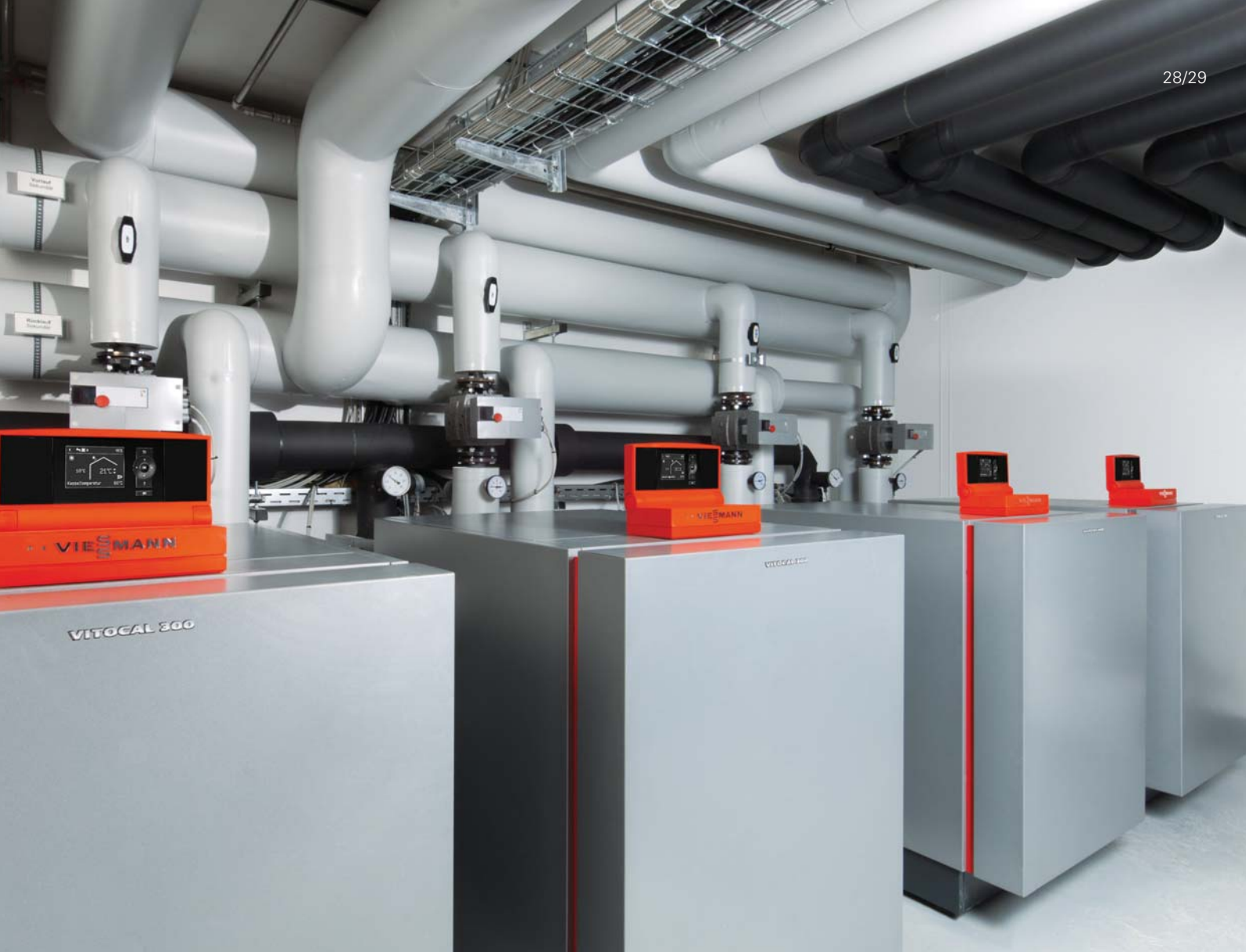
Zweistufige Vitocal 300-G (Master/Slave) als Sole/Wasser- bzw. Wasser/Wasser-Wärmepumpe
