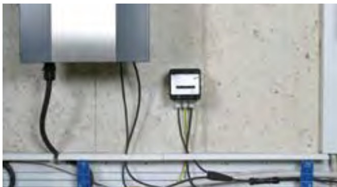
Vorkonfektionierte Anschlussleitungen zum komfortablen Anschluss der ankommenden Stringleitungen an DEHNCube und den Wechselrichter.
